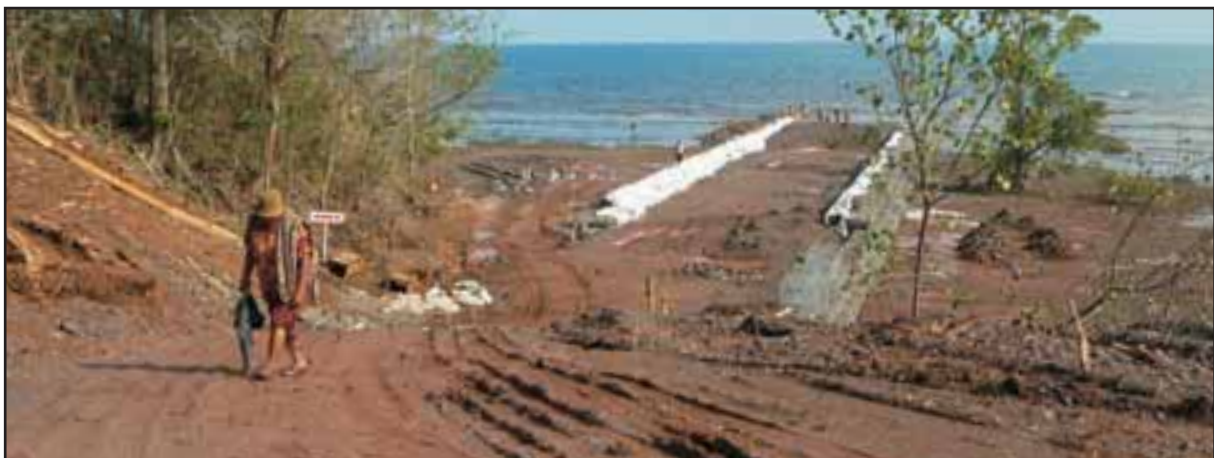
Pembangunan pelabuhan pabrik kayu serpih di Desa Alle-Alle
