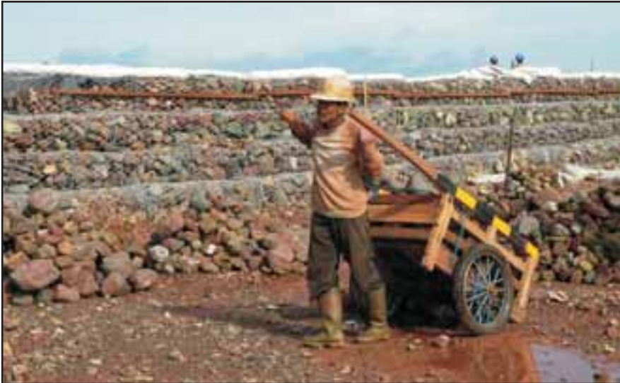
Pengumpul batu untuk pembangunan pabrik PT MAL di desa Alle-Alle
